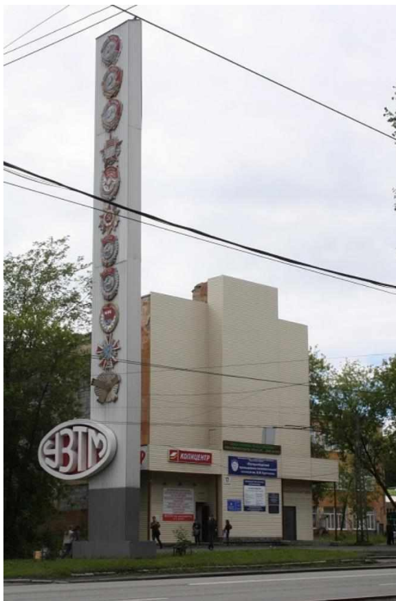
Учебный корпус (г. Екатеринбург, ул. Машиностроителей, 13)
